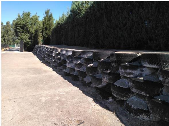
En la valorización material se utilizan tanto neumáticos enteros, por ejemplo, en la construcción de taludes, como triturados.
